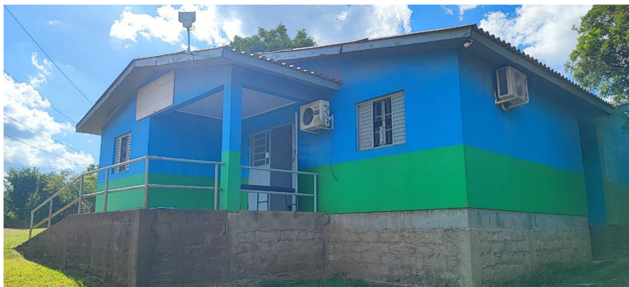
Foto 02/03 – Local onde será executada as obras
