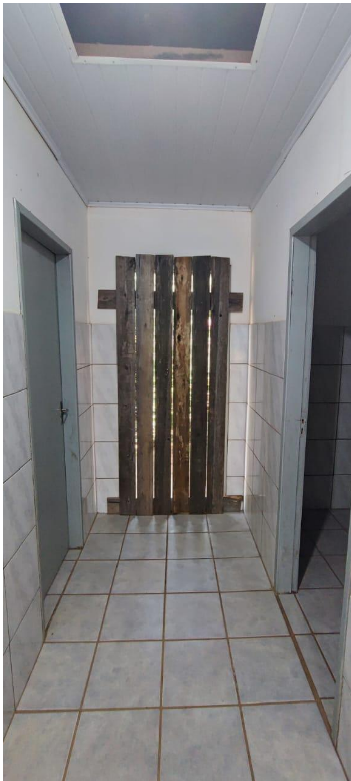
Foto 03/03 – Local onde será executada as obras
