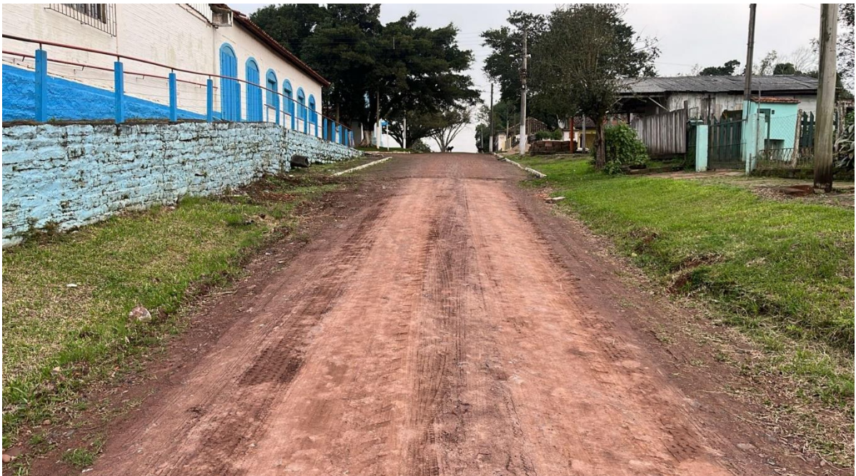
Foto 02/07 – Rua Demétrio Ribeiro_ início do trecho a ser pavimentado
