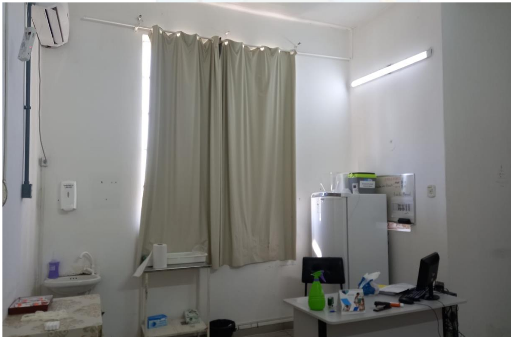
Foto 02/05 - Sala de acolhimento – destaque para abertura que será readequada
