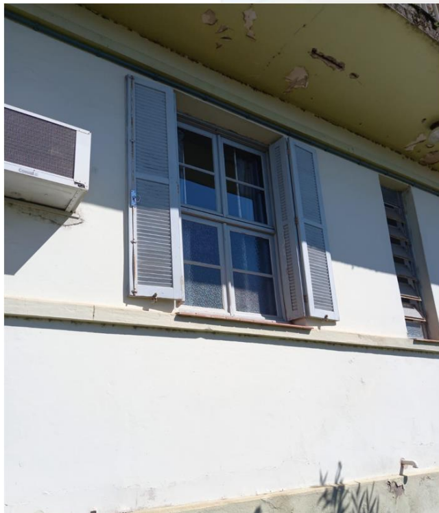
Foto 04/05 - Local onde será encaixada a rampa e escada de acesso à Sala de Vacina
