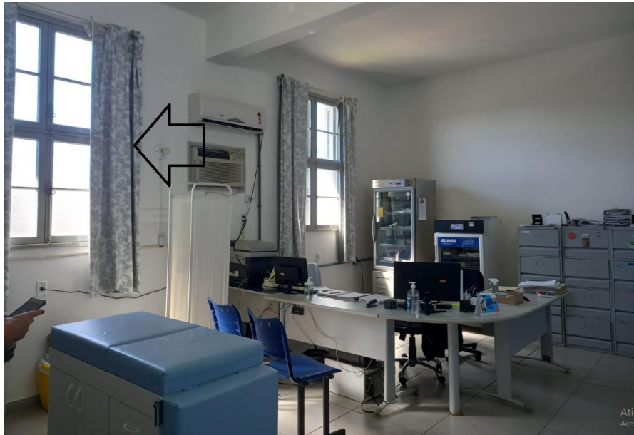
Foto 01/05 - Sala de Vacina – destaque para abertura que será readequada
