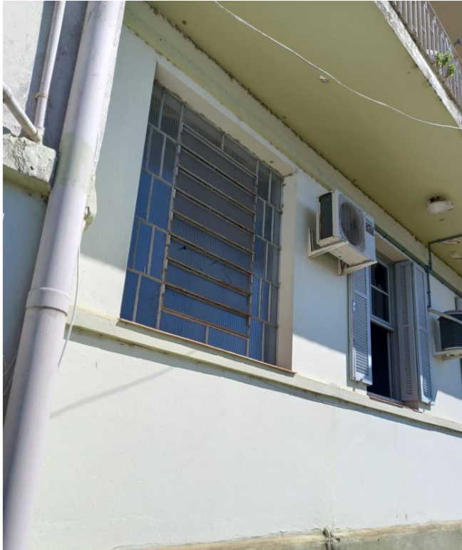
Foto 05/05 - Local onde será encaixada a rampa de acesso à Sala de acolhimento
