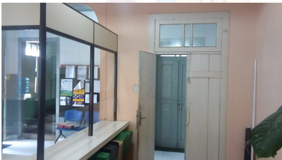
Foto 06/13 - Parede de tijolo cerâmico e vidro a ser demolida
