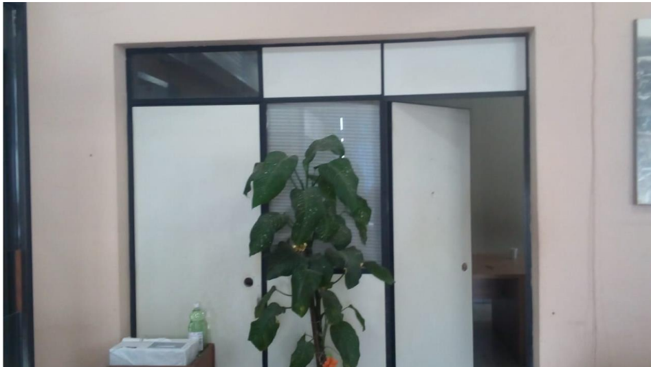
Foto 05/13 - Estrutura de gesso acartonado e vidro a ser removida
