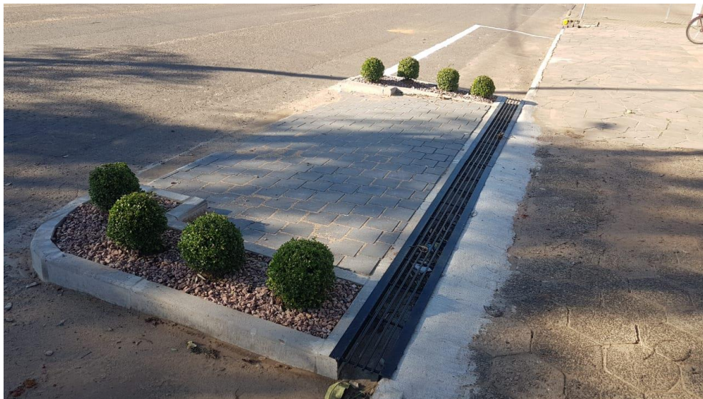
Exemplo da grelha metálica na lateral.
