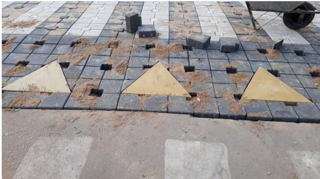
Exemplo da Faixa com Piso pigmentado e setas amarelas nas rampas.
