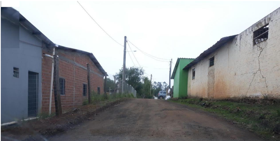
Foto 1 – Local onde será executado a Obra
