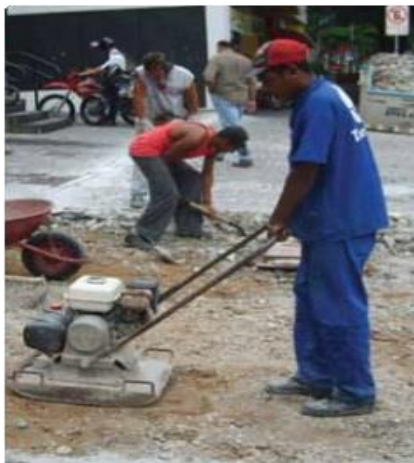
Figura 01 – Compactação do Subleito
